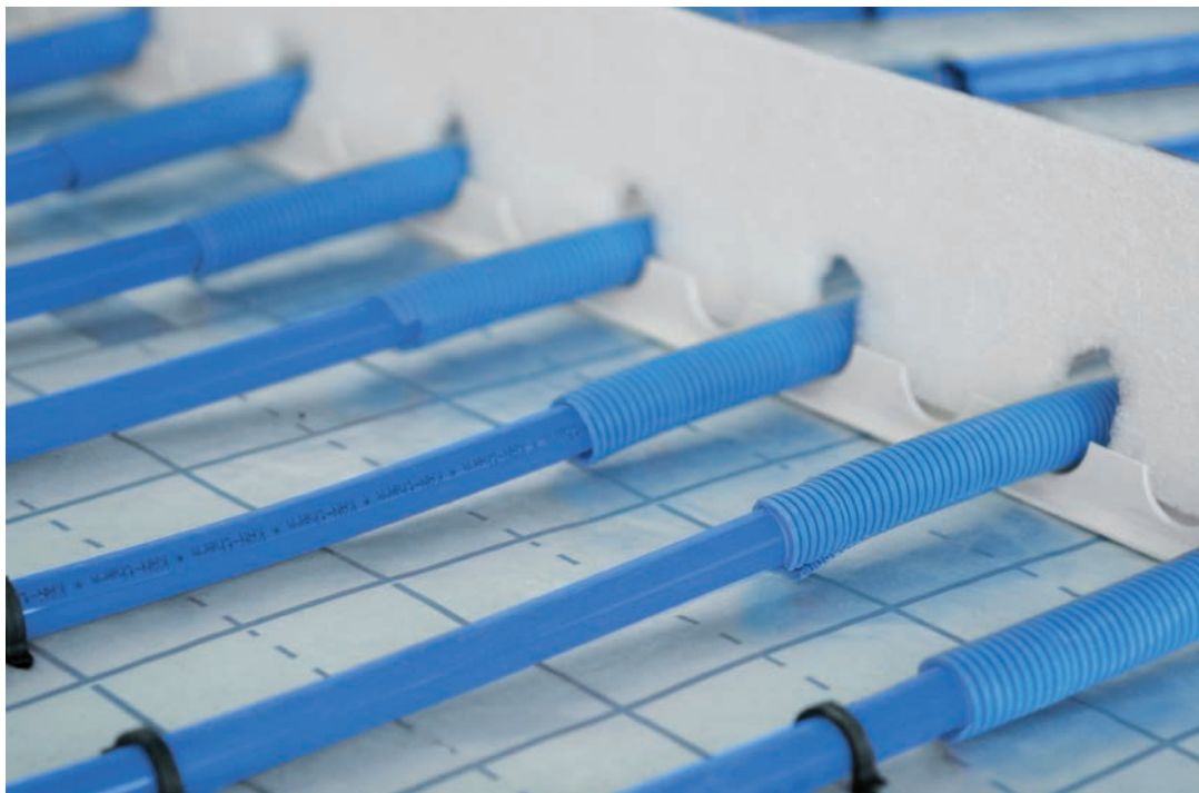
Att. 16. Kompensācijas profils - tranzīta cauruļu izvietošana caur kompensācijas šuvēm
